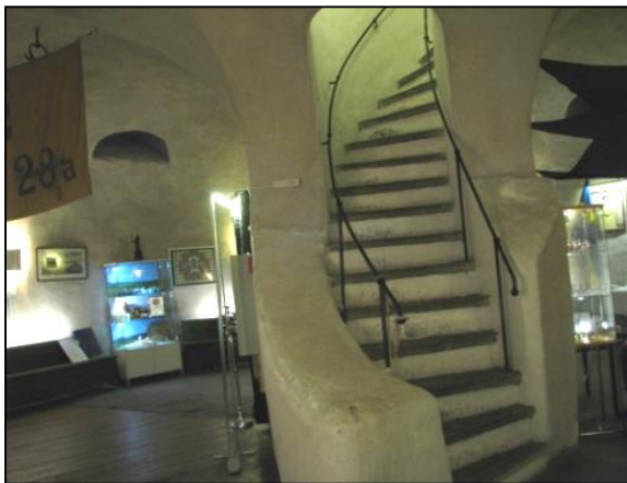
Trappan från entréväningen upp till nedre batterivåningen är skyddad mitt i Skansen Lejonets torn. Förbindelsen till övre batterivåningen är inbyggd i tornmuren och därvid, för att minska risken för rasing vid fientlig eld, på den minst hotade sidan, d.v.s. den som vetter mot huvudfästningen Göteborg.
